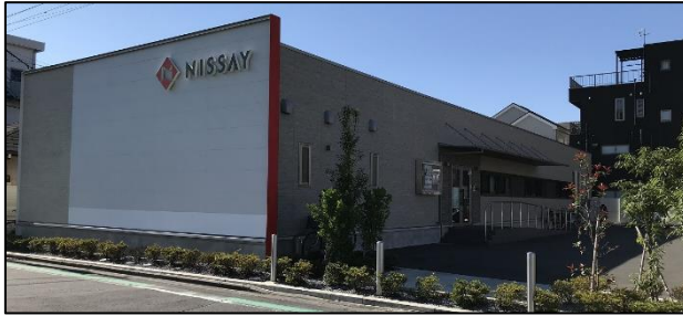
さいたま支社川口営業部 外観
