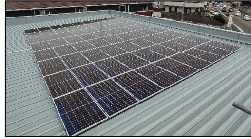
和歌山支社伏虎営業部 屋上
