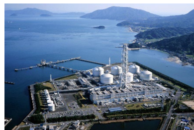
【柳井発電所外観】
