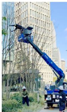
高所作業車での作業
