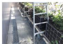
立馬での作業と手が届きやすいように配慮したプランターの欠き込み
