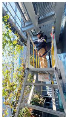
立馬での作業と手が届きやすいように配慮したプランターの欠き込み
