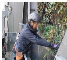
ゴンドラでの作業
