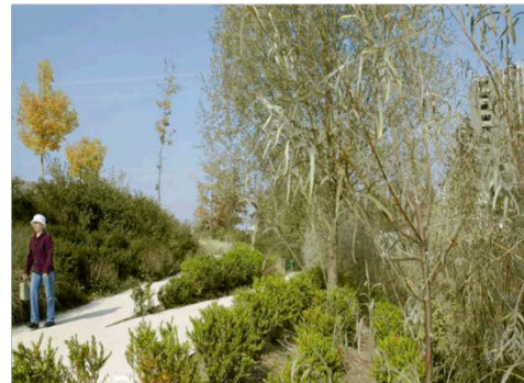
○公園の建設現場
