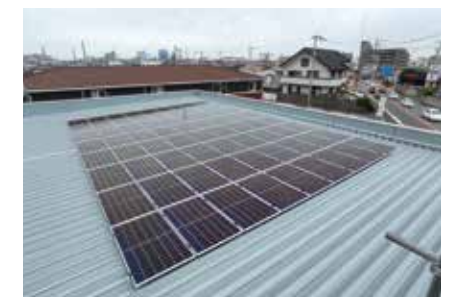
和歌山支社伏虎営業部 屋上
