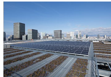
日本生命本店（東館）屋上
