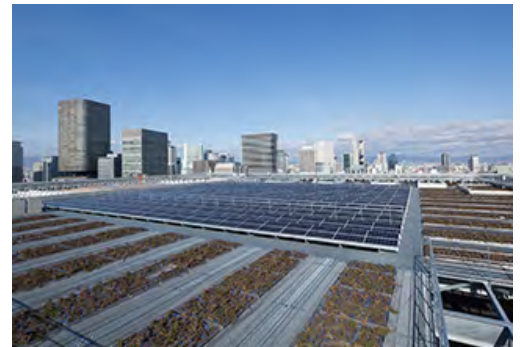
日本生命本店（東館）屋上
