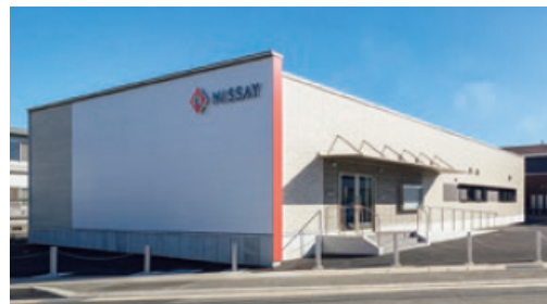
和歌山支社伏虎営業部
