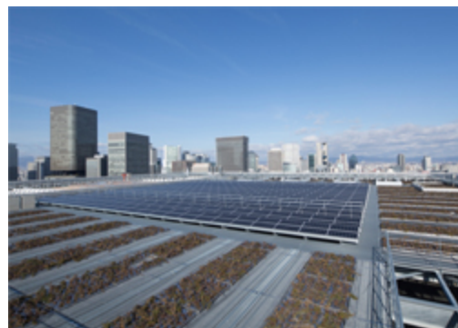
日本生命本店(東館) 屋上
