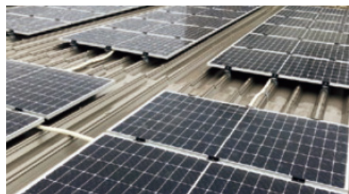
さいたま支社桶川営業部 屋上
