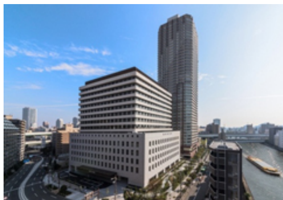
日本生命病院外観
