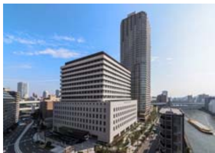
日本生命病院外観
