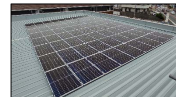
伏虎営業部 屋上
