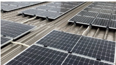
さいたま支社桶川営業部 屋上
