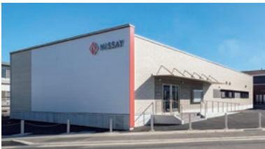
和歌山支社伏虎営業部
