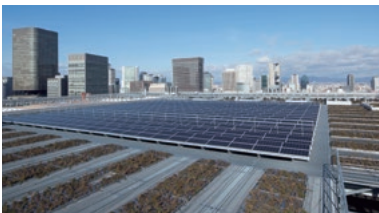
日本生命本店(東館) 屋上
