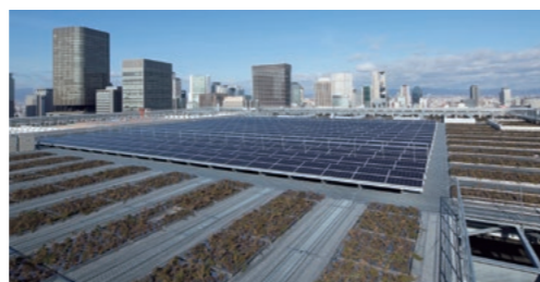
日本生命本店(東館) 屋上
