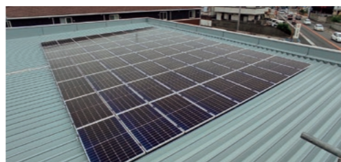
和歌山支社伏虎営業部 屋上
