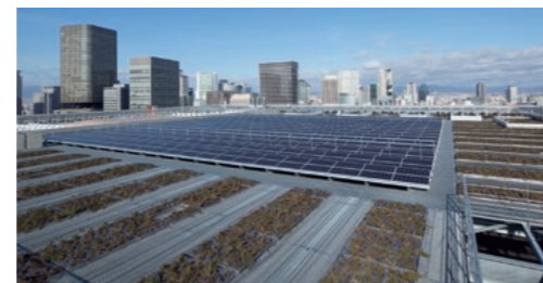
日本生命本店(東館) 屋上
